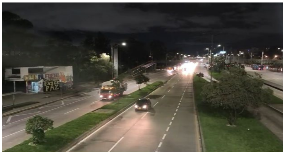
Imagen 30 Universidad Nacional NQS- Fotografía proporcionada por personal en vía
