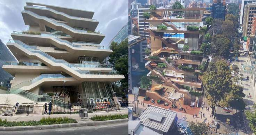
El Centro de Felicidad de Chapinero, días antes de su inauguración, y a la derecha infografía del equipo arquitectónico. El equipamiento se conforma como una Alameda Vertical e introduce el concepto de parque vertical, con diez pisos, más de 10.500 metros cuadrados y una altura de casi 45 metros.
